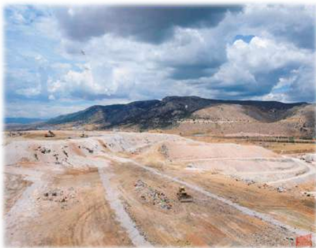
Άποψη του ΧΥΤΑ Φυλής τον Ιούνιο του 2014
