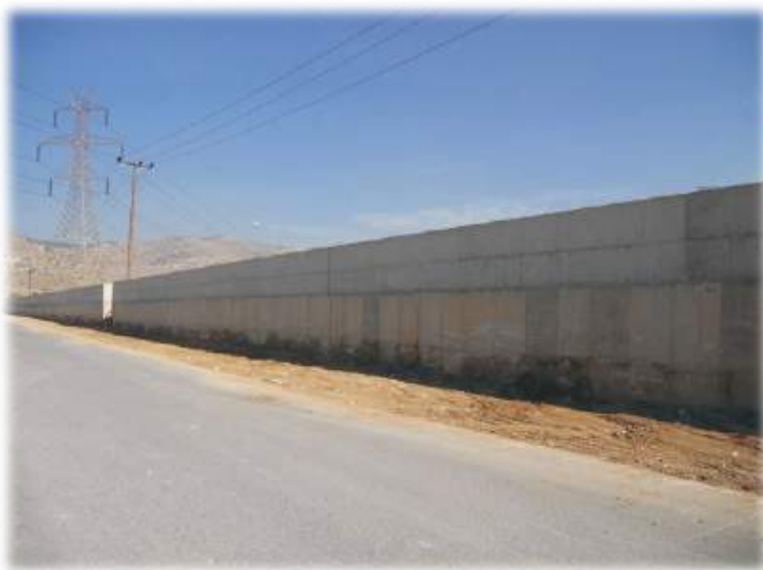
Υπερύψωση της περίφραξης στο Δυτικό Τμήμα του ΧΥΤΑ
