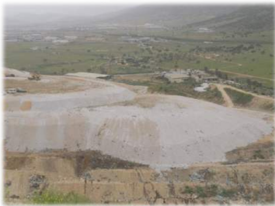
Άποψη του ΧΥΤΑ Φυλής τον Απρίλιο του 2013
