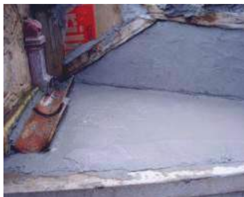
Στέγη μετά την επισκευή
