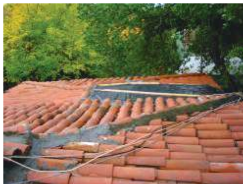
Στέγη μετά την επισκευή
