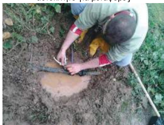
Επισκευή διαρροής αρδευτικού δικτύου του Πεδίου Άρεως
