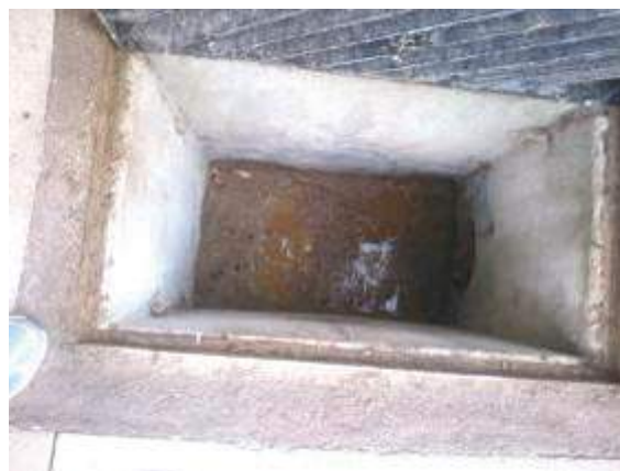
Καθαρισμός φρεατίων μετά
