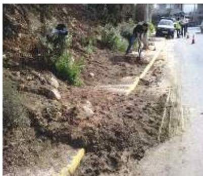
Απομάκρυνση χωμάτων από κατολίσθηση πρανών στον περιφερειακό δρόμο
