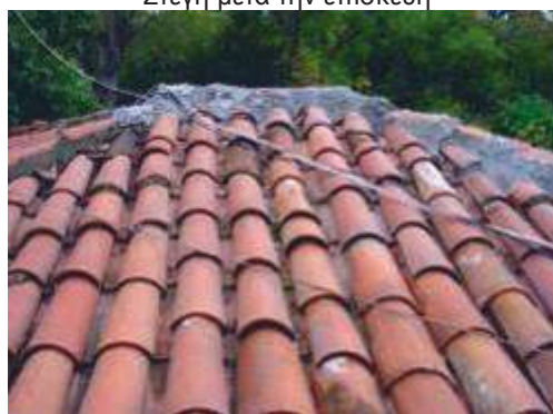
Στέγη μετά την επισκευή
