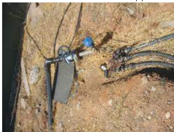
Κάλυψη σωλήνων άρδευσης και τοποθέτηση φρεατίου
