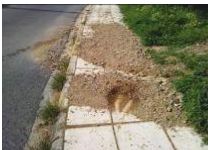
Απομάκρυνση χωμάτων από κατολίσθηση πρανών στον περιφερειακό δρόμο
