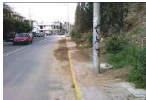
Απομάκρυνση χωμάτων από κατολίσθηση πρανών στον περιφερειακό δρόμο
