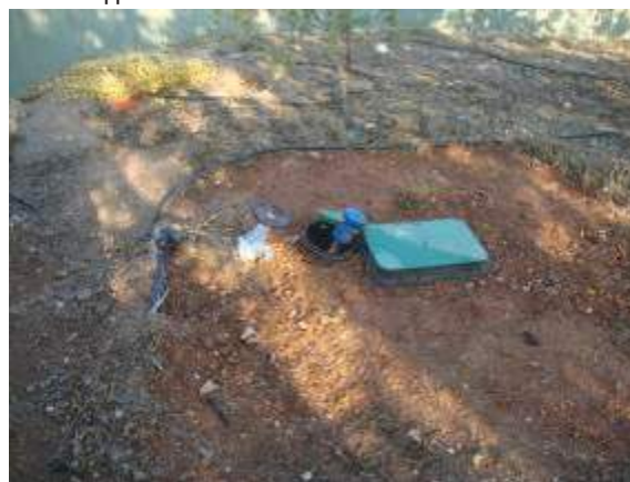
Κάλυψη σωλήνων άρδευσης και τοποθέτηση φρεατίου
