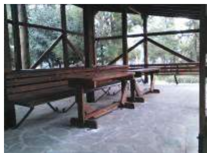
Κατασκευή τραπεζιού σε κίосκι
